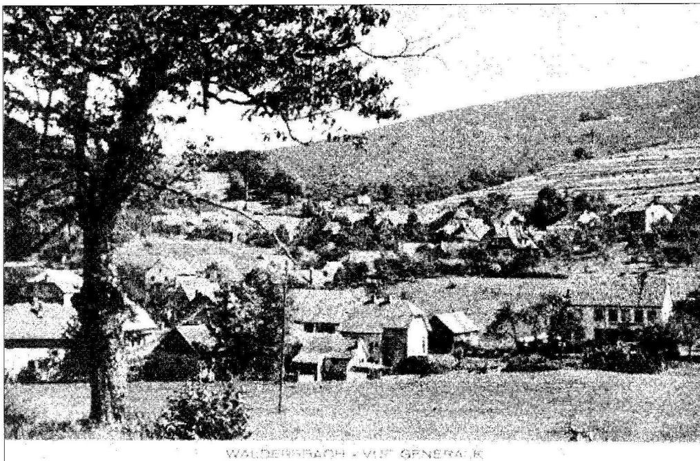
WALDERSBACH - VUE GÉNÉRALE
